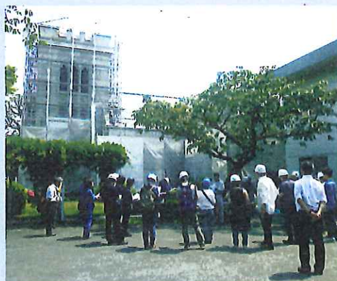
【横浜山手聖公会】大谷石施工現場見学会の様子
