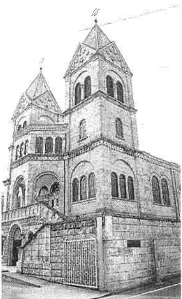
壁には大谷石が使われ、国の有形文化財に登録されているカトリック松が峰教会。宇都宮市松が峰1丁目
