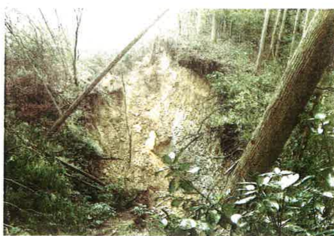
今年2月の陥没現場（大谷地域整備公社提供）
